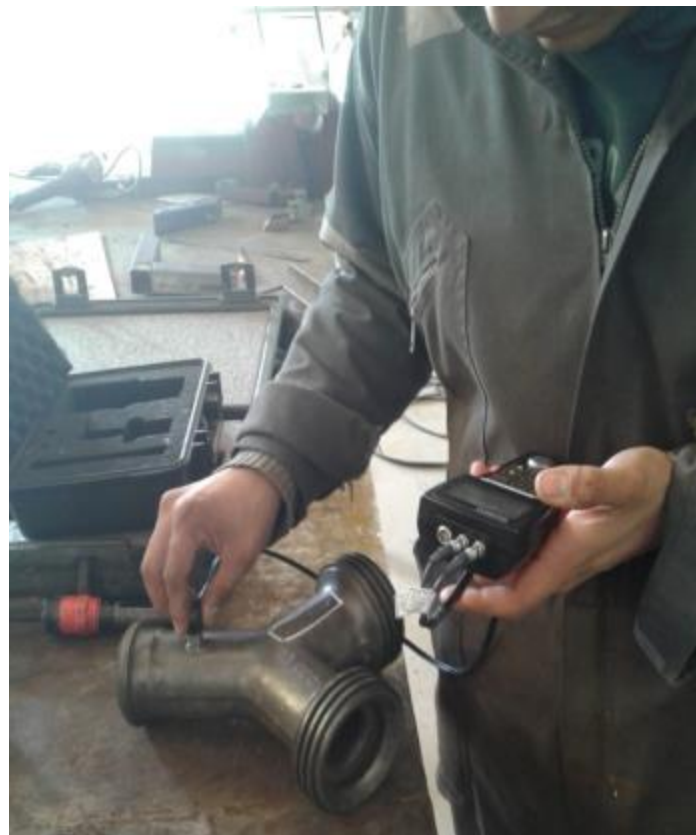
Medición de espesor por ultrasonido realizado a componente de alta presión
