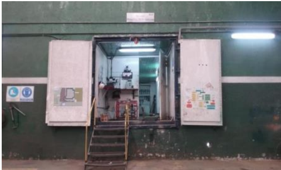
Vista frontal del bunker de pruebas hidrostáticas
