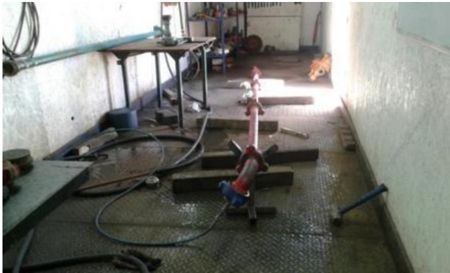
Línea de alta presión armada lista para ser probada dentro del bunker
