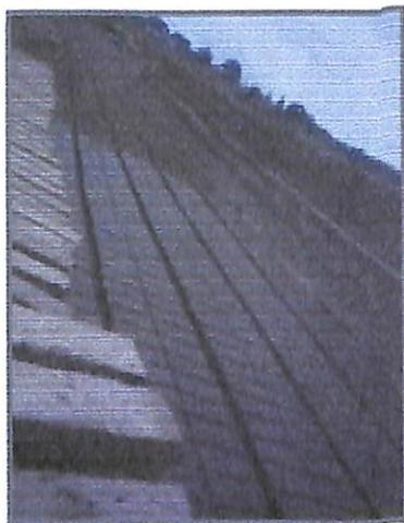
Foto 12: Hileras de ladrillos crudos
