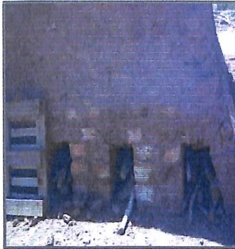
**Foto 17:** Boquillas en las que se deposita la leña para realizar la quema
