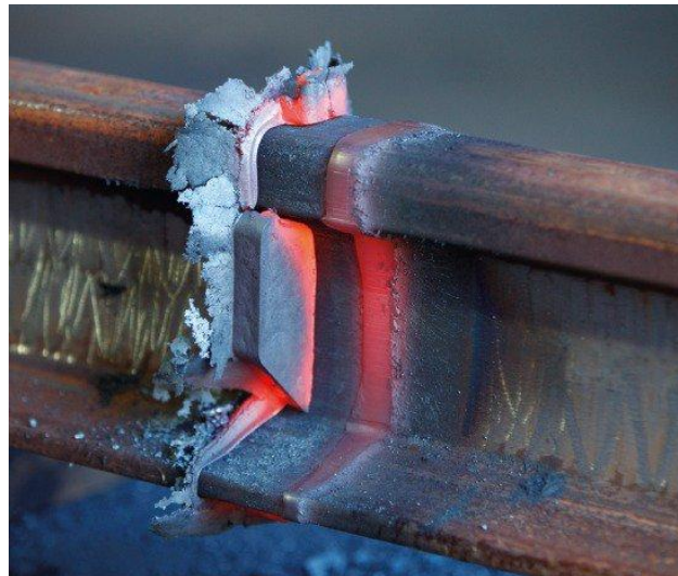
Figura 2. 5 Soldadura cuproaluminotérmica para unión de rieles.
