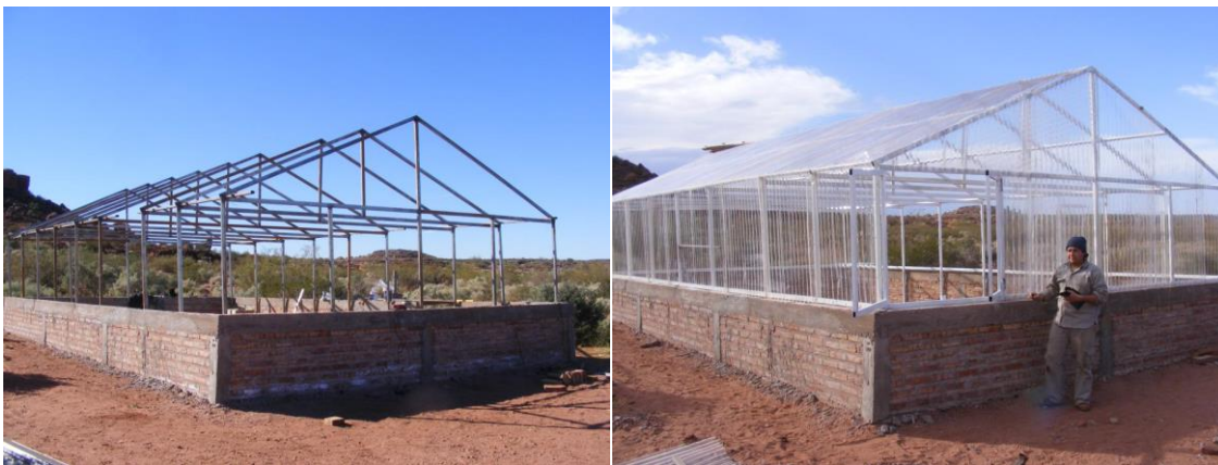
Figura 74. Etapas en la construcción del invernadero del vivero R.
