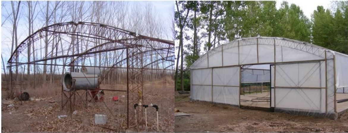
Figura 37. Vista externa inicial y final del invernadero. La tarea incluyó armado de una platea y retiro de viejas estructuras.
