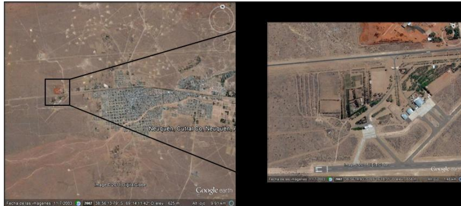
Figura 24. Vista satelital de la localidad de Neuquén y ubicación del vivero de Cutral Cò en el recuadro. El vivero se ubicó en la periferia de la ciudad. Se observan explanadas petroleras y caminos en los alrededores de la ciudad.
