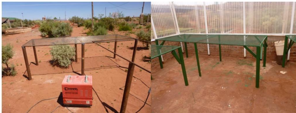
Figura 76. Vistas de las etapas de construcción de mesadas de trabajo.
