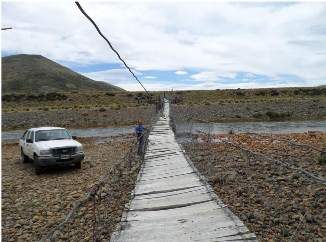
Figura 2.8: Pasarela existente en Paraje “La Y” (Vista general del tablero, el cable principal y cables de soporte de la malla de resguardo).
