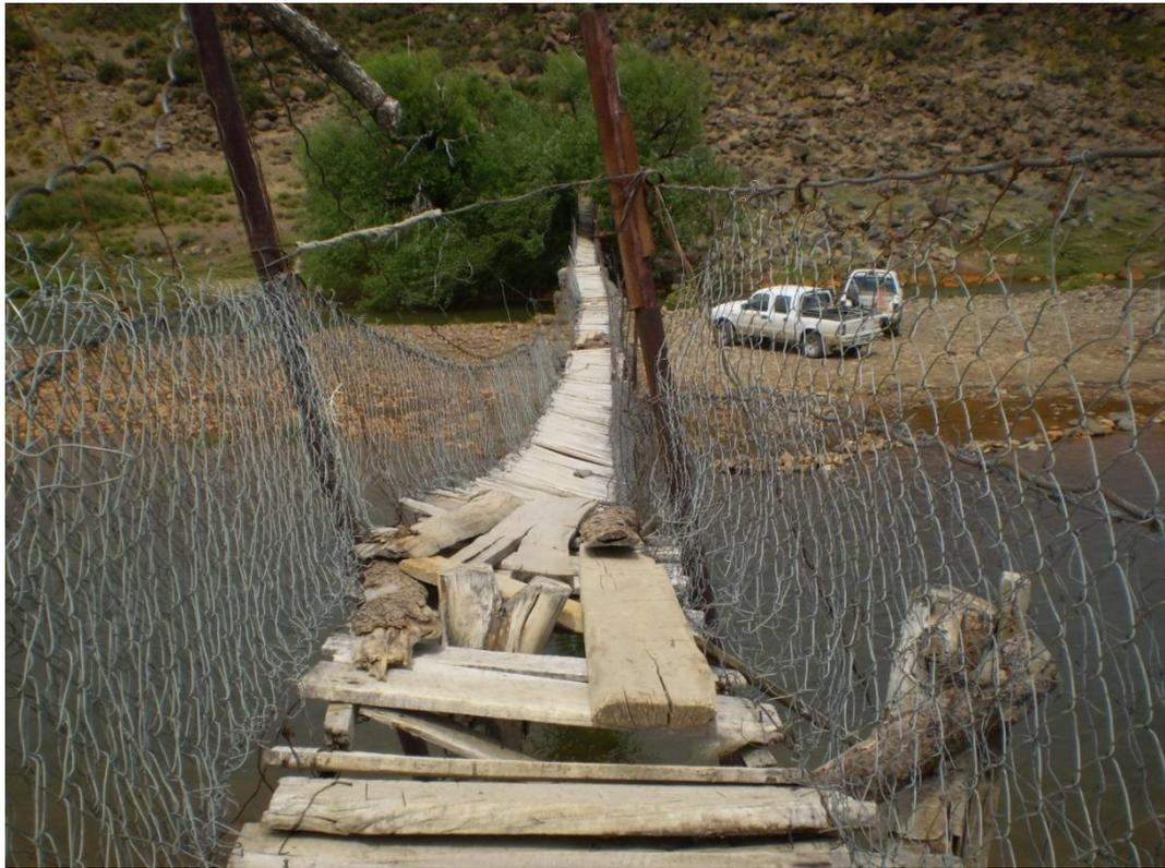
Figura 2.9: Estado del tablero de la pasarela existente.
