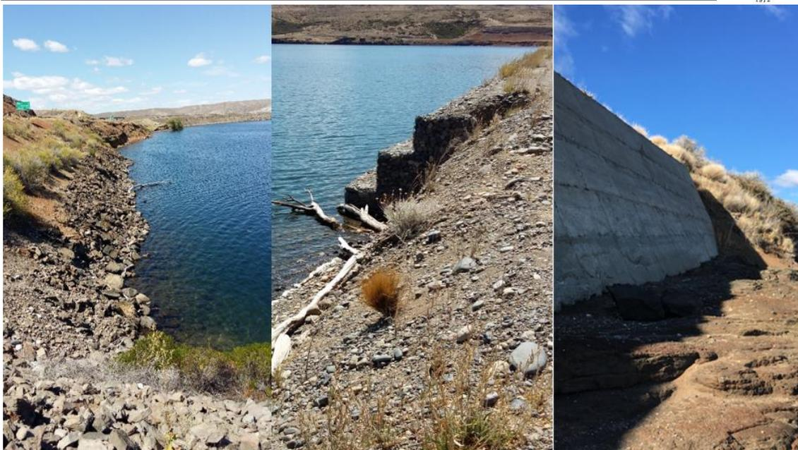
*Fotos 1 - Fuente: elaboración propia. Sistemas de protección contra la acción del agua del embalse.*
