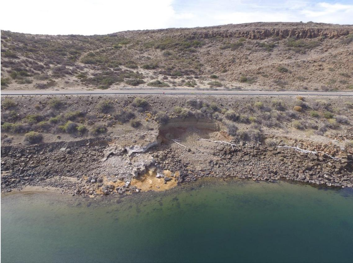
*Fotos 7 - Fuente: elaboración propia. Desmoronamientos producto de la acción del agua sobre el terraplén no protegido.*
