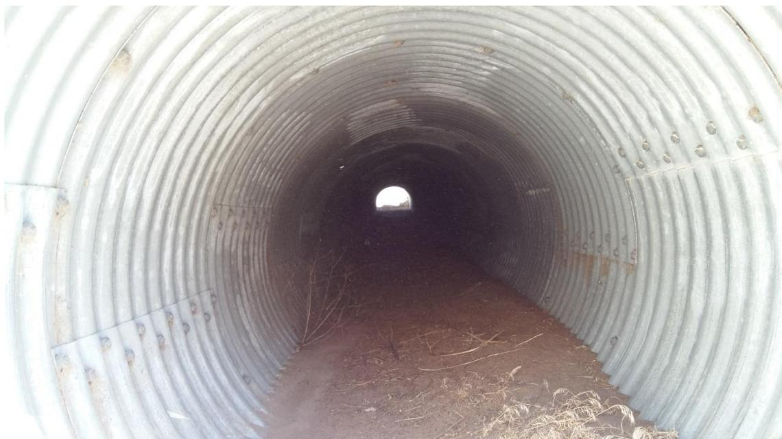
*Ilustración 13 – Fuente: elaboración propia. Alcantarilla bajo progresiva 56,46 de la RN N°234.*
