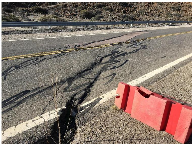
Ilustración 10 – Fuente: elaboración propia. Línea cronológica de avance de la fisura.
