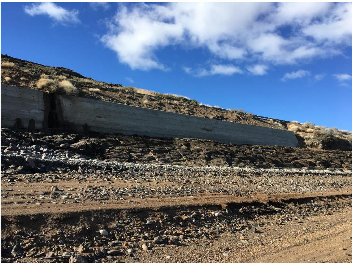
*Fotos 22 - Fuente: elaboración propia. Base de asiento del muro sobre roca no meteorizada.*
