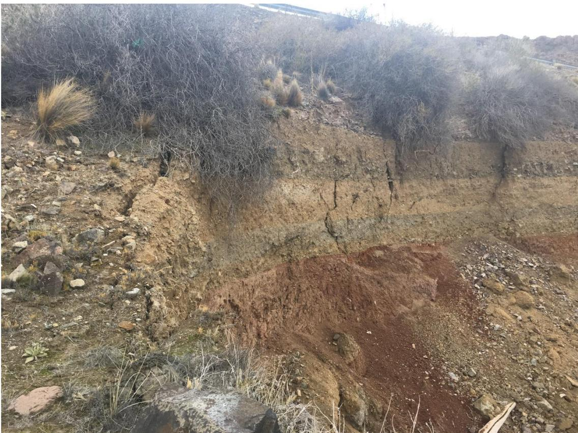
*Fotos 10 - Fuente: elaboración propia. Láminas de suelo próximas a desprenderse.*
