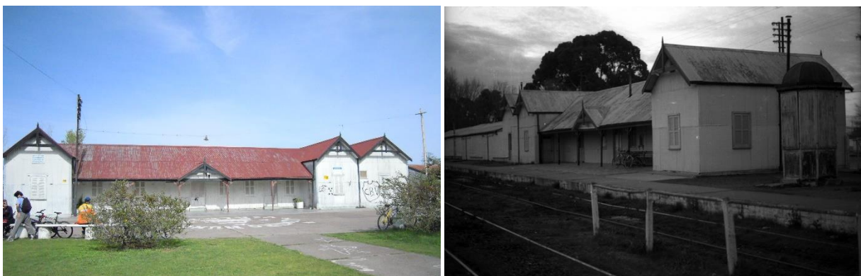
Fig. 4. La ex Estación de Ferrocarril Noroeste antes y ahora. Enfoque histórico-patrimonial. Fuente: http://museotaller.blogspot.com/2014/04/arquitectura-ferroportuaria-estacion.html
