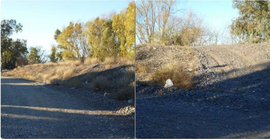
Imágenes N°7 y N°8. Terraplen, defensa de contención ante crecidas del caudal del río Neuquén en el B° R. de Emilio. Vista de distintos sectores de la defensa de contención ante crecidas fluviales
