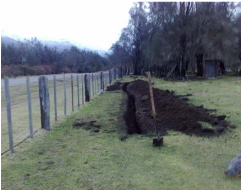
Zanja de protección
