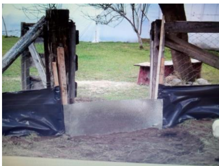
Barrera de acceso al predio
