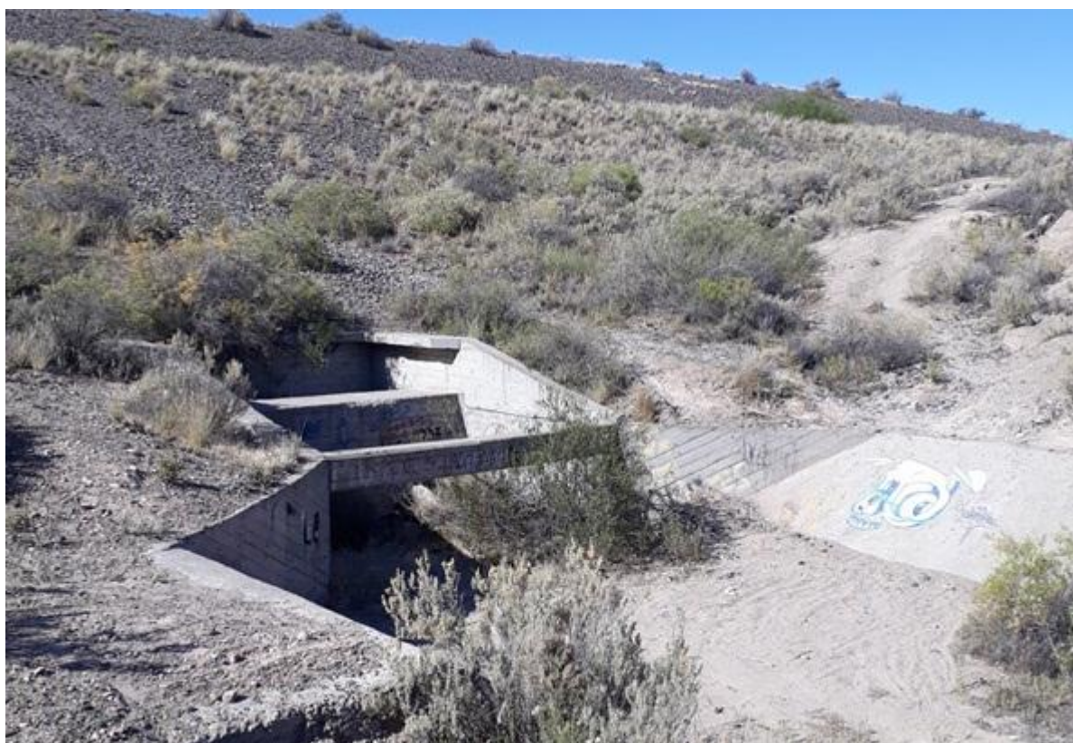
Imagen 12. Vista general, disipador de energía.
