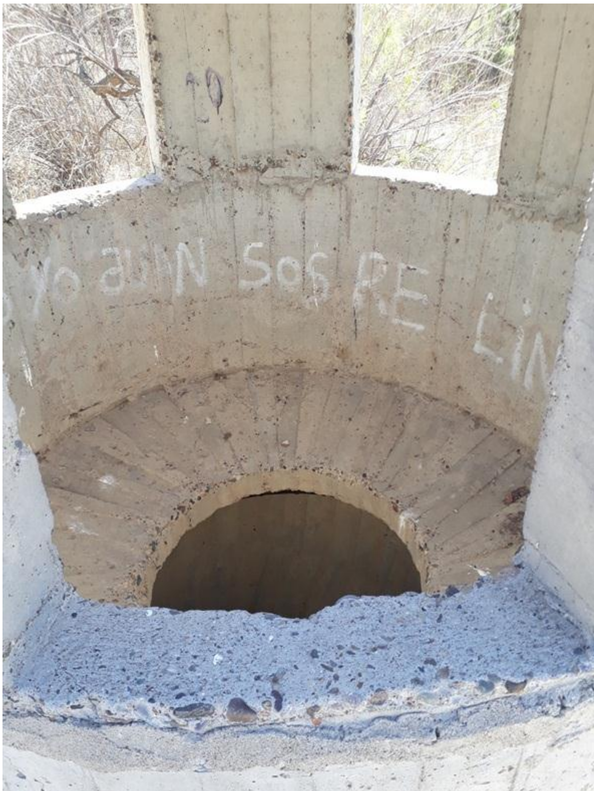
Imagen 6. Interior descargador de fondo, toma izquierda.
