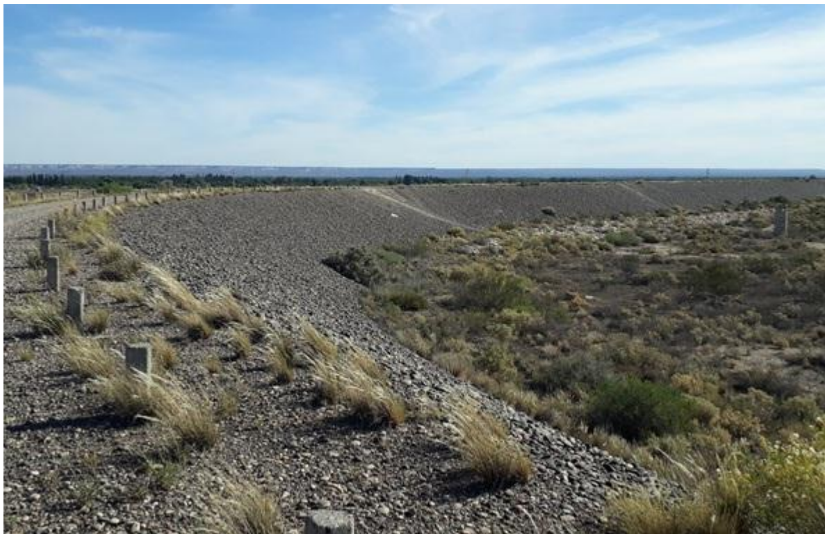
Imagen 1. Vista general presa de contención aluvional.
