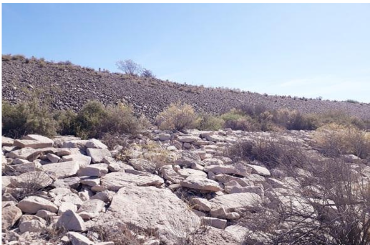
Imagen 2. Talud aguas arriba.
