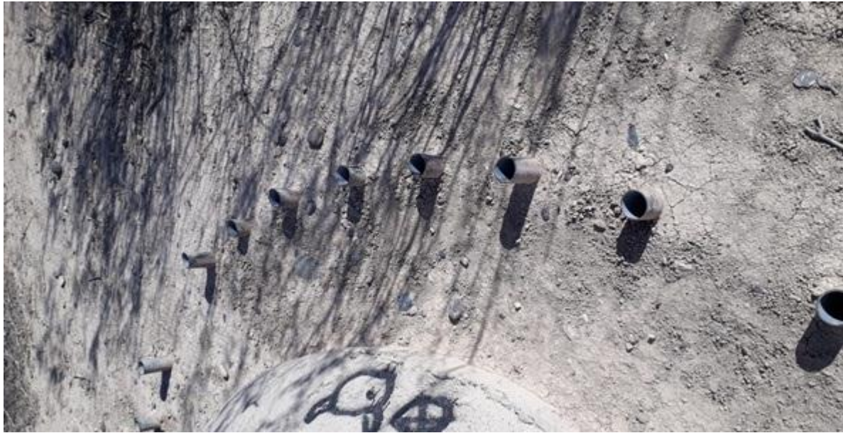
Imagen 9. Ausencia de rejas tubulares, toma derecha.
