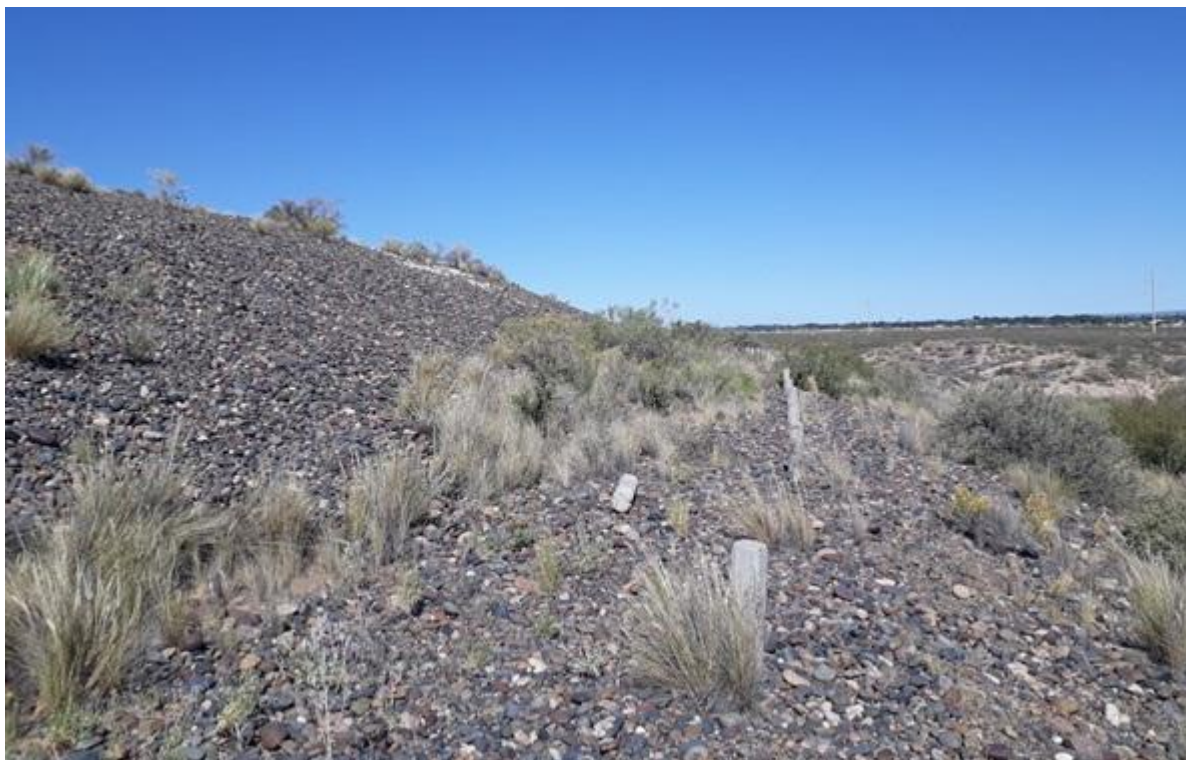
Imagen 3. Talud aguas abajo.
