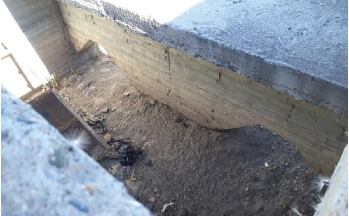
Imagen 13. Disipador de energía, salida izquierda.
