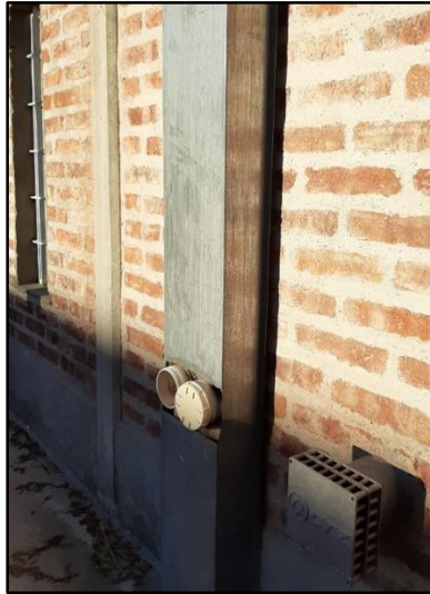
Figura 9. Ingreso de fibra óptica al edificio LaMHi.
