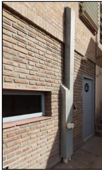
Figura 15. Ingreso de la fibra óptica al Edificio de Petróleo – Química.
