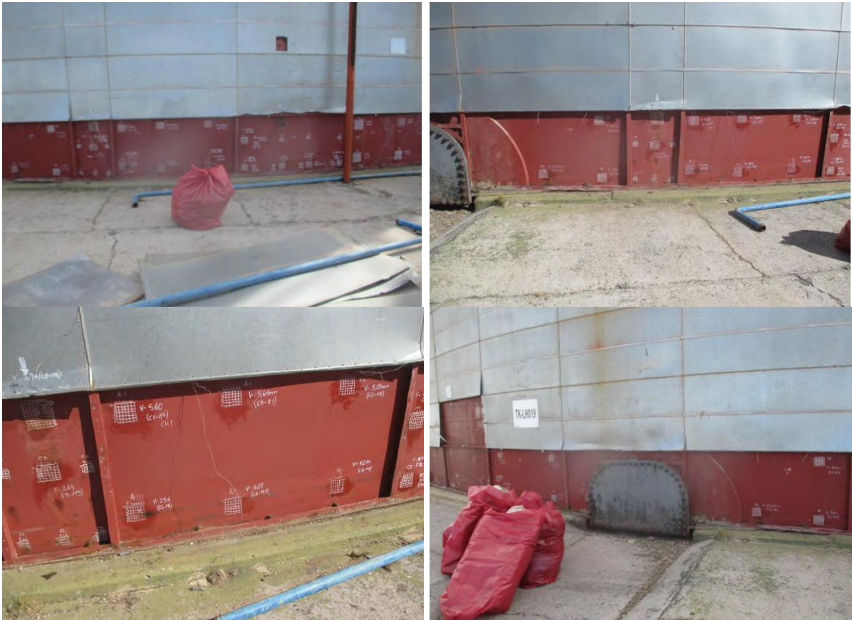
Figura 3.11: Cuadrículas de medición sobre la envoltura en la primera virola.
