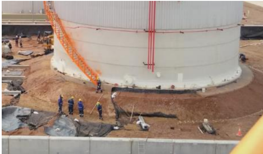
Figura 4.2: Conformación del terraplén, platea perimetral y anillo de hormigón de un tanque API 650 (2013).
