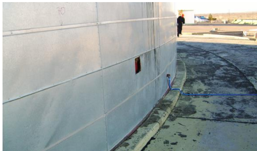
Figura 4.3: Fundación del tanque en estudio.
