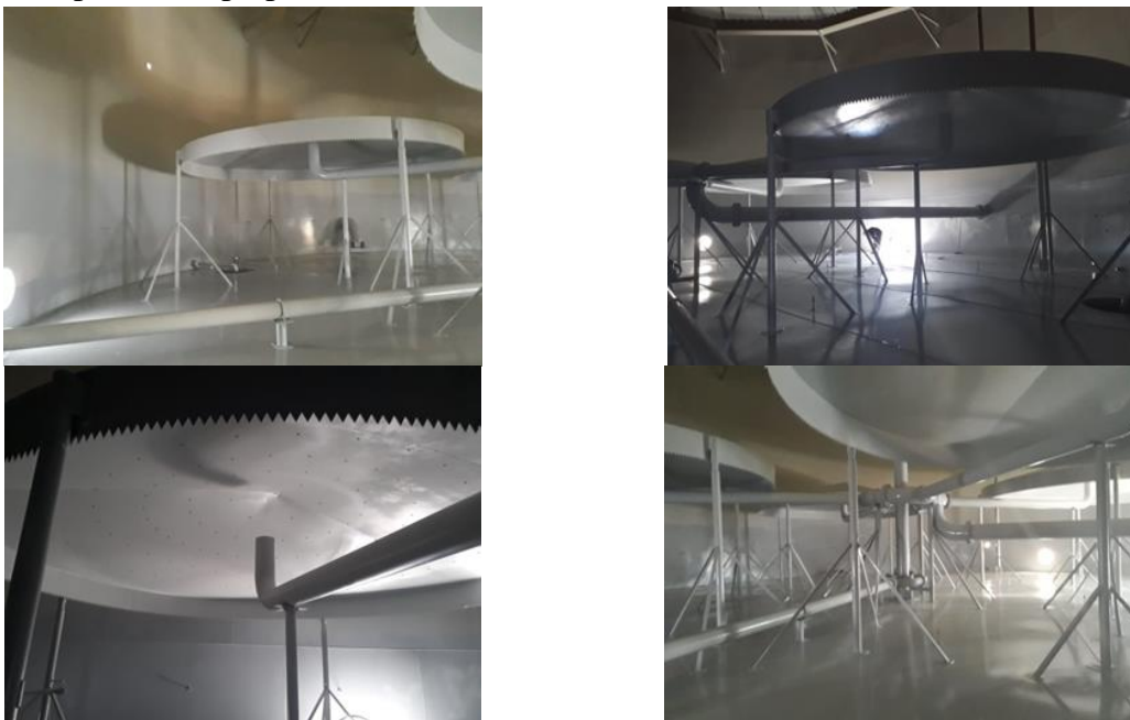
Figura 2.11: Tipologías de placas deflectoras tipo arañas.
