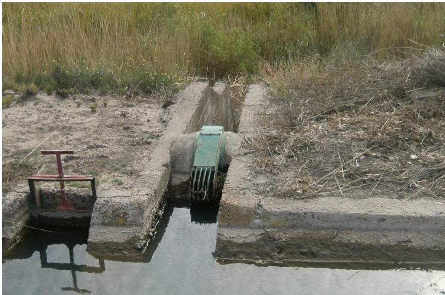
Imagen 4: Sifón autocebante en el canal secundario VII
