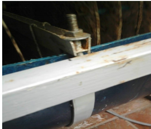
Figura 10 Ajuste de placa divisoria de compartimentos mediante perfil de aluminio y faja metálica con extremos roscados.
