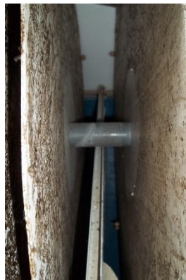
Figura 13 Tubo separador de paquetes de discos cruzando sobre placa divisoria de compartimentos.
