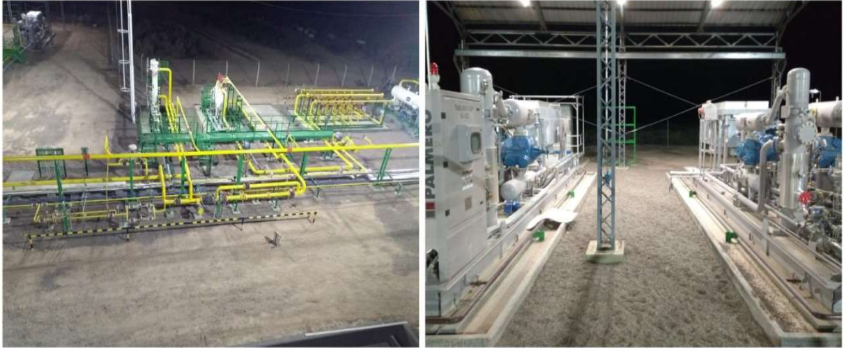
Imagen 28: Obra 202 en horario nocturno.
