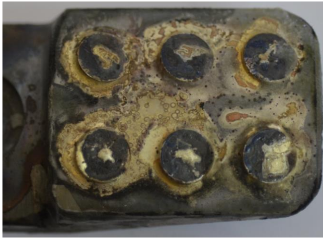
Figura 9 Muestra con acabado superficial insatisfactorio.
