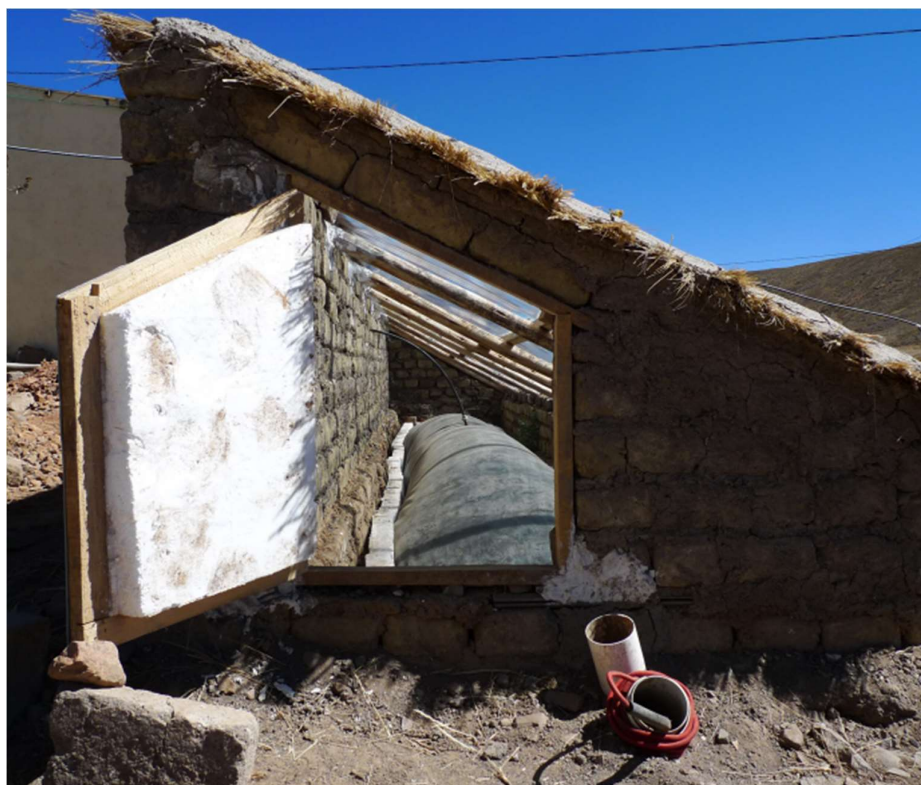
Figura 9: Biodigestor tubular con adaptaciones de bajo costo a climas fríos (Martí Herrero, 2019).
