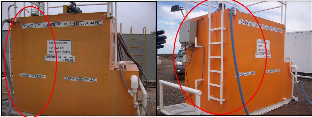
**Figura N°2.7:** Cámara de Aireación.
