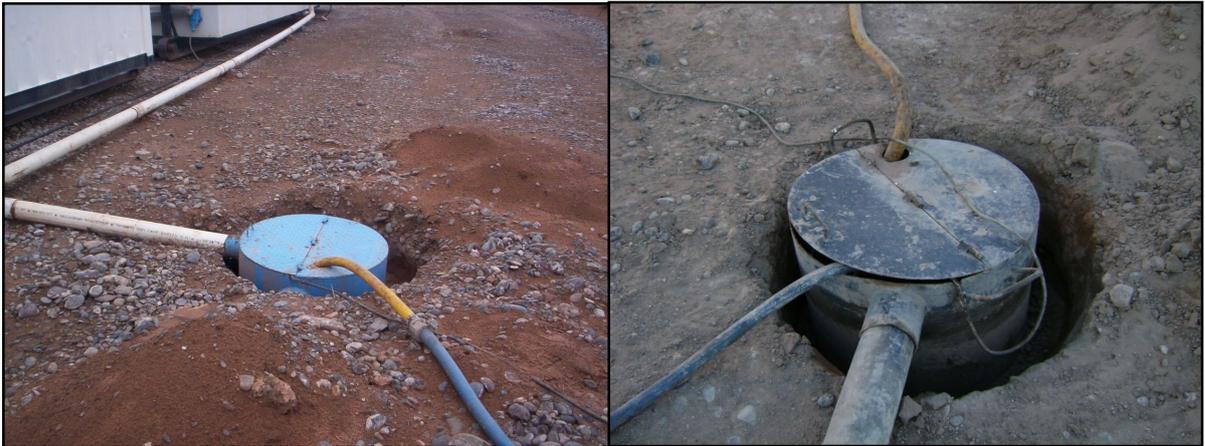
**Figura N°2.3:** Cámara de Pre-tratamiento instalada en suelo
