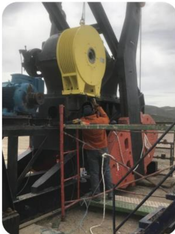
Figura 3-10: Montaje de motor de imán permanente- CIPOR S.R.L (2020)
