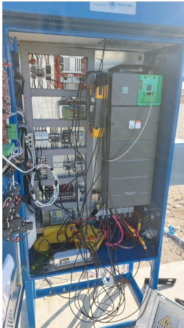
Figura 3-12: Colocación de equipo Fluke en variador de frecuencia
