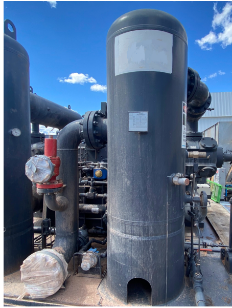
Figura 7. Scrubber de primera etapa.
