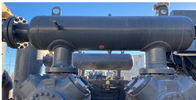
Figura 11. Botellón amortiguador de pulsaciones de primera etapa de succión.
