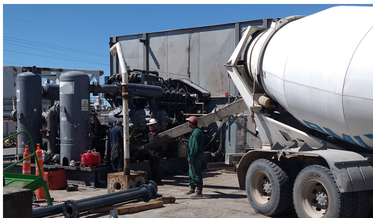
Figura 31. Colocación de cemento en patín.
