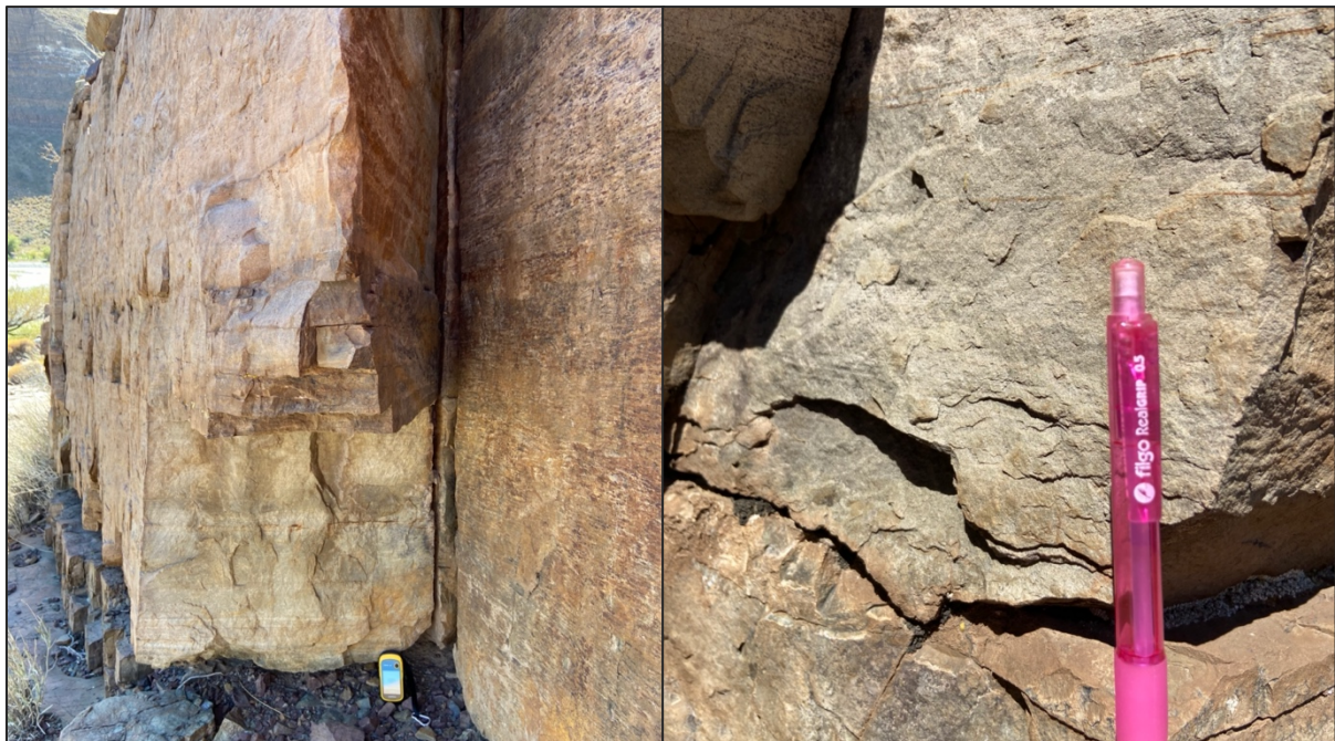
Figura 23. Diaclasas correspondientes a la familia de discontinuidades J1. En: a) Diaclasa con una extensión de 1 m y abertura de 1 cm con ausencia de relleno; b) Rugosidades y alteración en las paredes de la discontinuidad.
