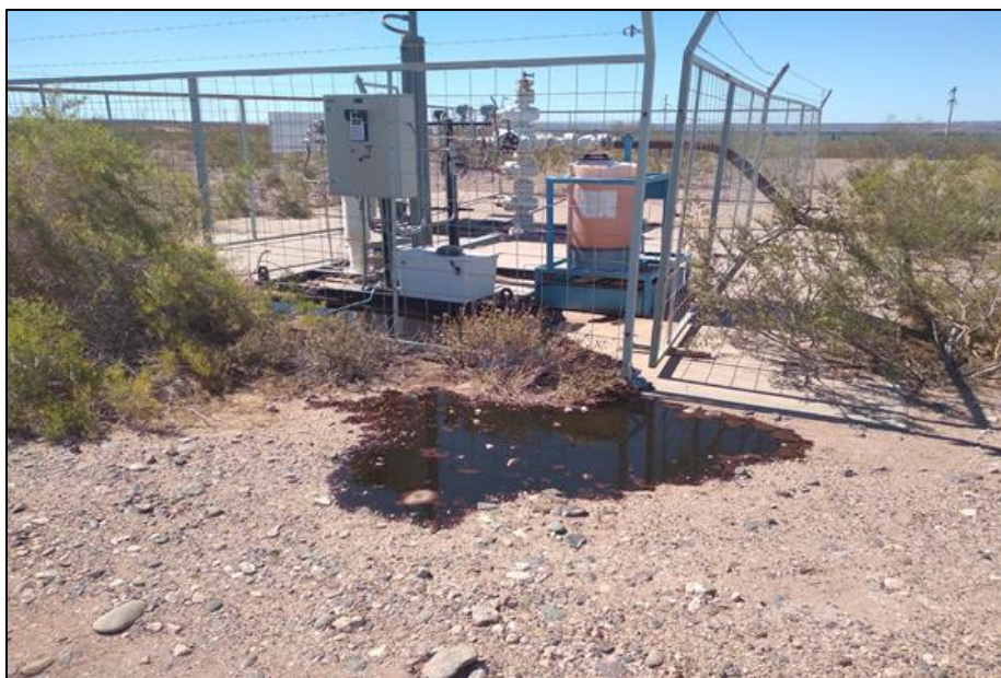
Foto N°1: Derrame menor de Hidrocarburo sobre suelo.
