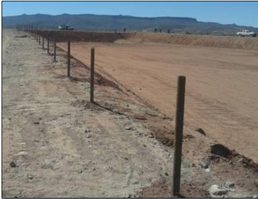
Foto N°4: Repositorio en etapa de construcción.
