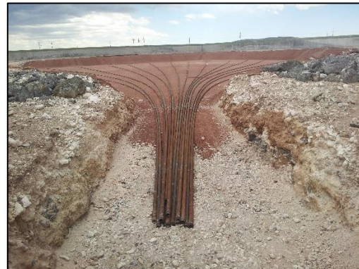
Foto N°5 y 6: Colocación de sistema de captación de lixiviados.
