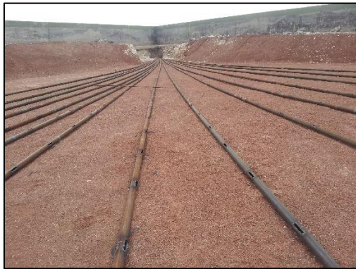
Foto N°5 y 6: Colocación de sistema de captación de lixiviados.
