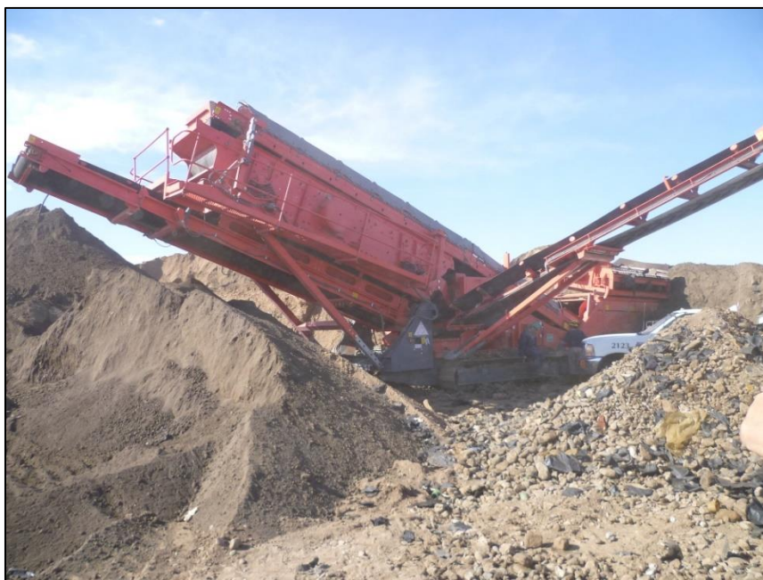
Foto N°9: Segregadora en operación.
