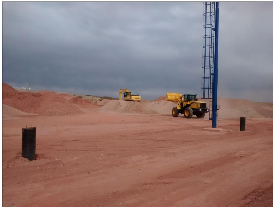
Foto N°7: Proceso de acopio de material y segregado.
