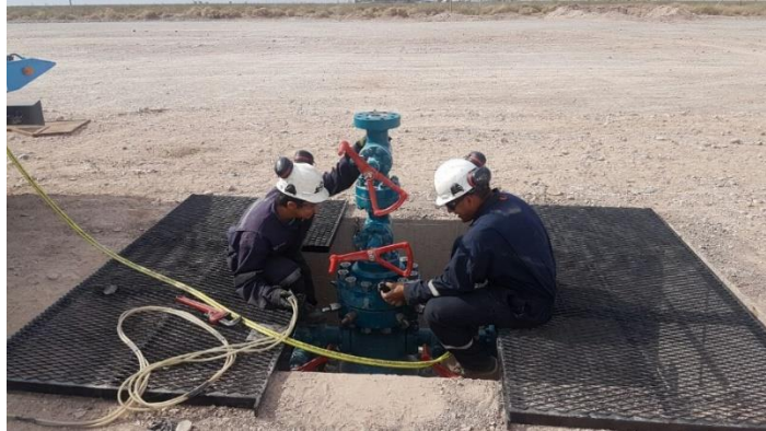
Imagen 25. Torque de BOP. Fuente: Propia
