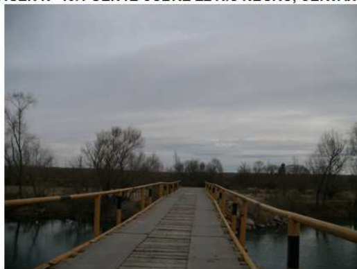
IMAGEN N° 46. PUENTE SOBRE EL RÍO NEGRO, CERVANTES.
