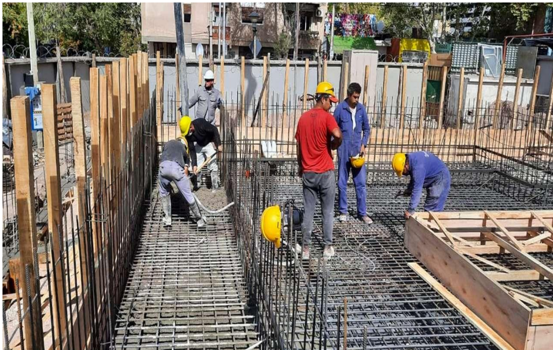
Construccion nuevo edificio y bunker Hospital Provincial Neuquen
