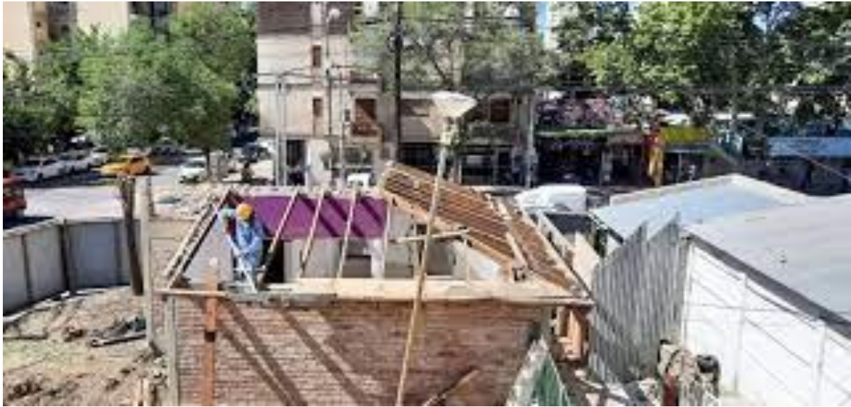
Construcción bunker Hospital Provincial Neuquén
