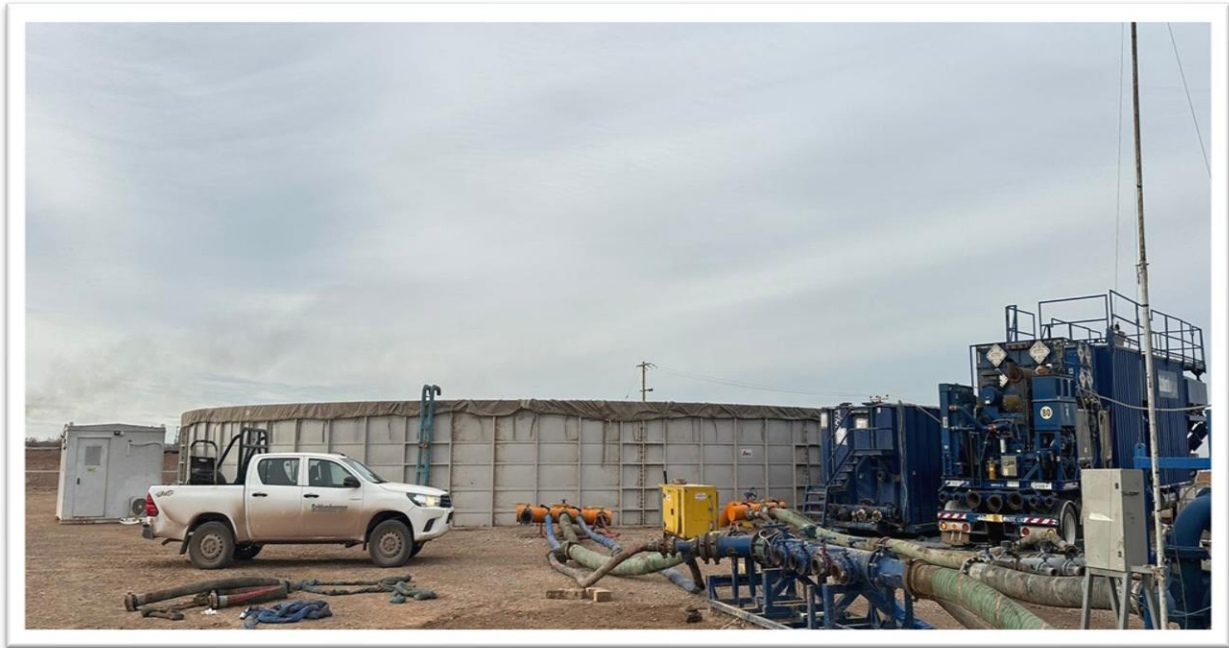
Figura 20. Piletos de agua dulce en locación Pad-32.
