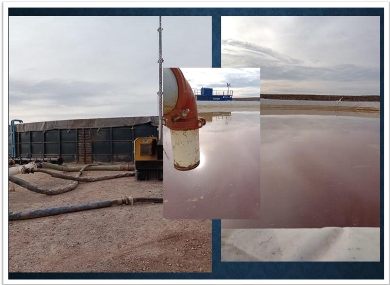
Figura 19. Piletones de agua de producción especialmente contruidos en tierra, que cumplen de manera estricta con las normativas ambientales establecidas, garantizando un revestimiento adecuado para su almacenamiento seguro y controlado.
