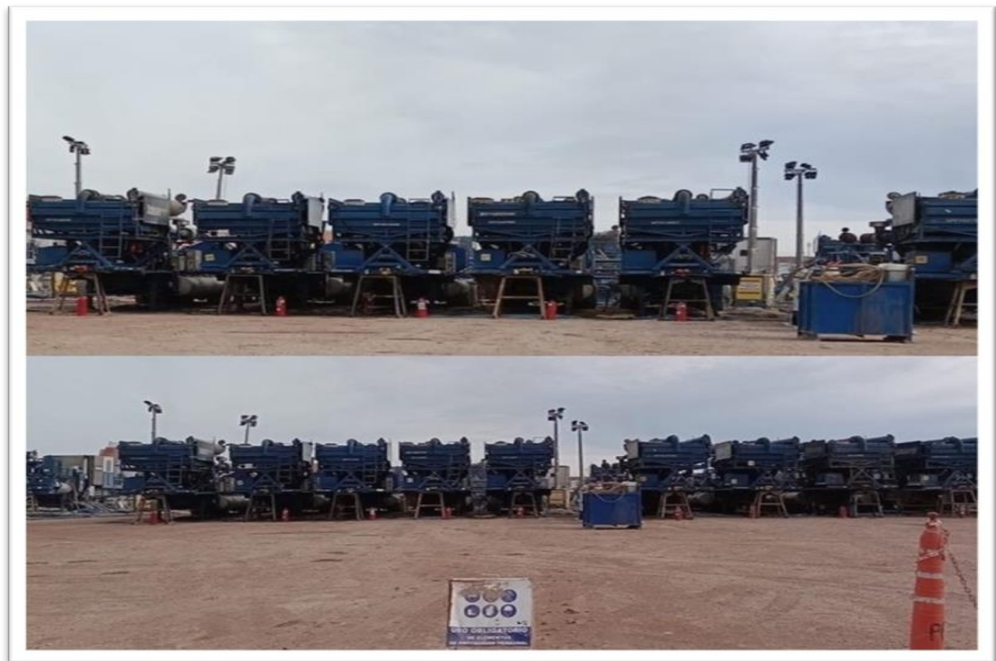
Figura 17. Bombas de fractura ( Frac Pumps ) en locación.
