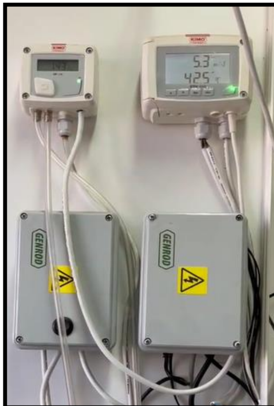
Figura 5.7: Sensores de presión y velocidad para monitoreo del sistema
