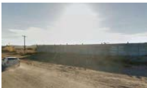
Foto B. Paredón de cemento protegiendo un elemento tecnológico de la industria del petróleo (Pozo o Boca).
