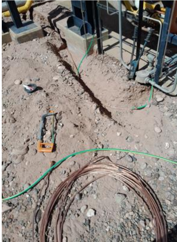
Ilustración 9: Trabajos de adecuaciones de Puesta a tierra
