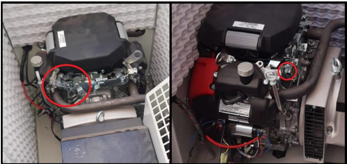
Ilustración 29: Punto regulación rpm del motor del generador
