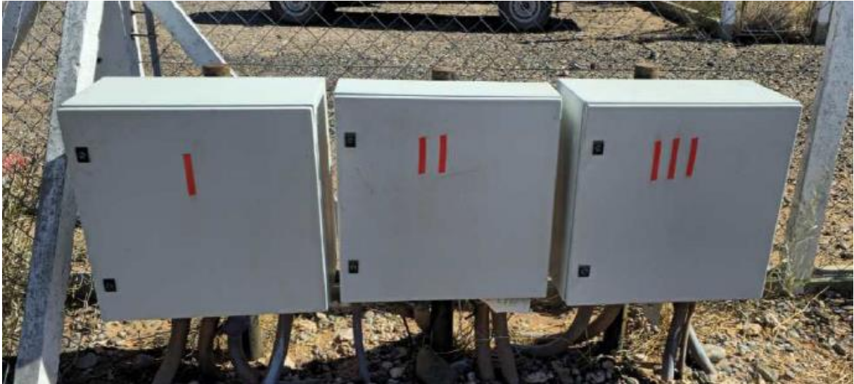
Imagen 16: Tableros de interconexión
