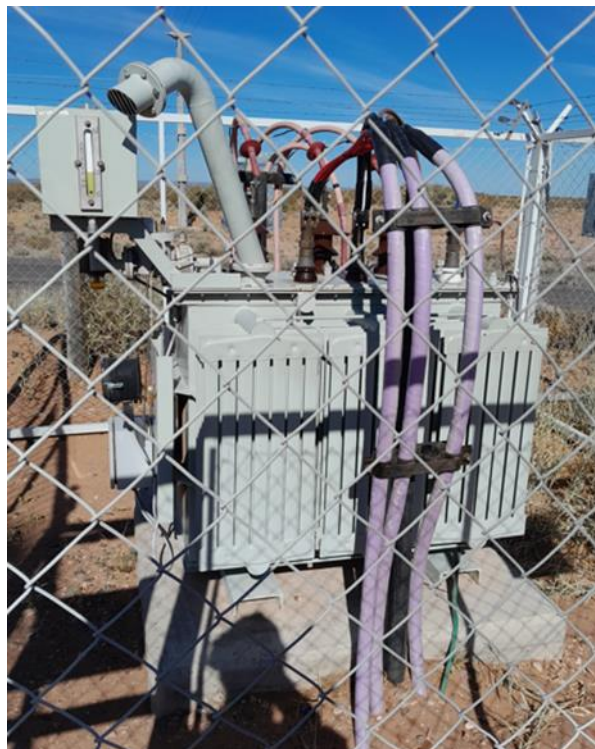
Imagen 18: Transformador elevador de tensión 0,38/0,48kV de bomba 753 (hay uno por cada bomba)
