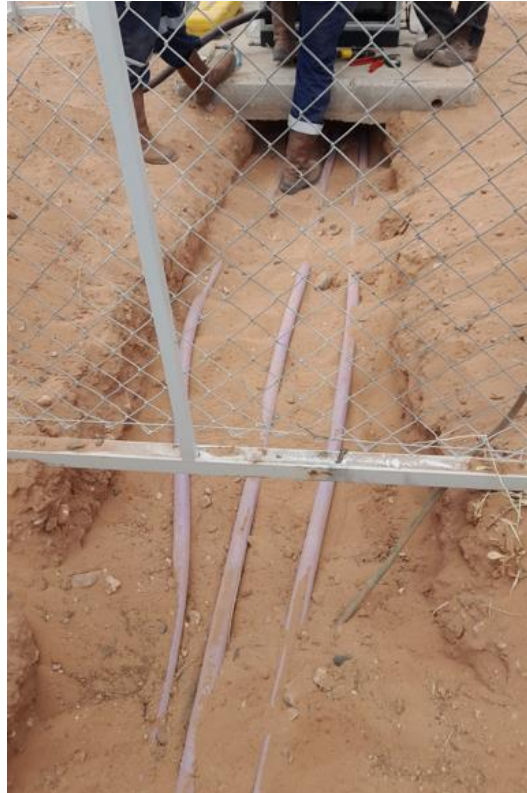
Imagen 20: Cambio de conductores de salida del transformador MT/BT hacia tablero principal BT
