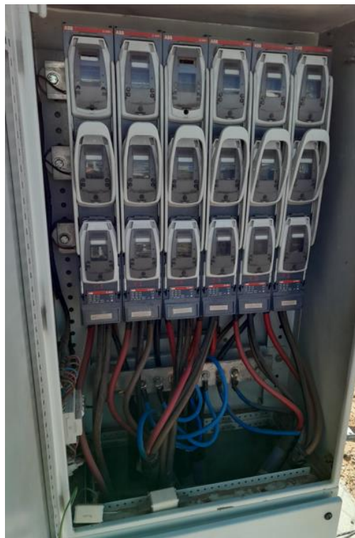
Imagen 16: Tableros de interconexión
