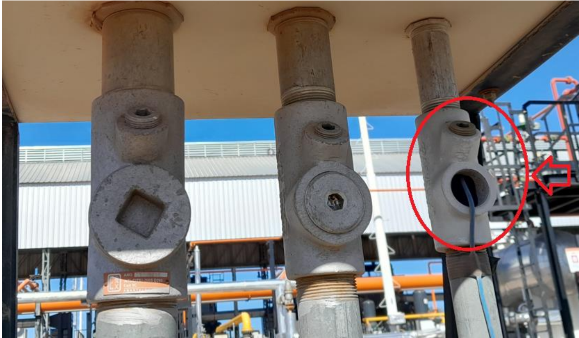
Imagen 33: desvío detectado en Tablero VDF B
