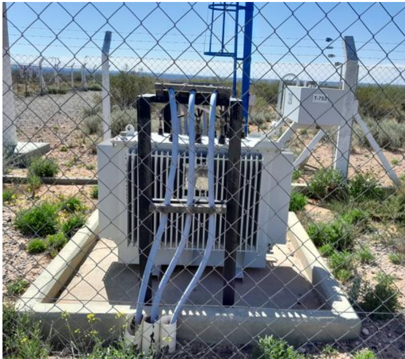
Imagen 18: Transformador elevador de tensión 0,38/0,48kV de bomba 753 (hay uno por cada bomba)
