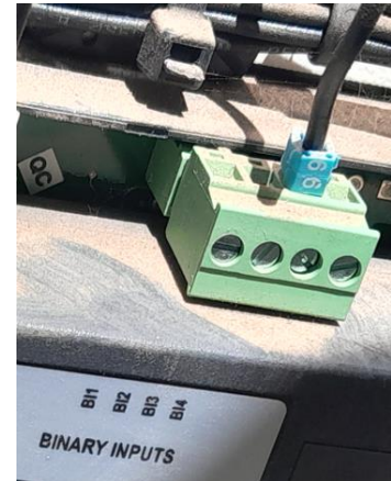
Ilustración 64: Entradas binarias en controlador TTA de otra instalación
