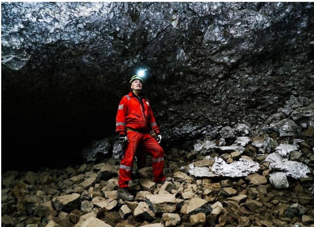
Figura 6-13: Brecha de colapso en la entrada a la Sala del Lago (pared sur).
