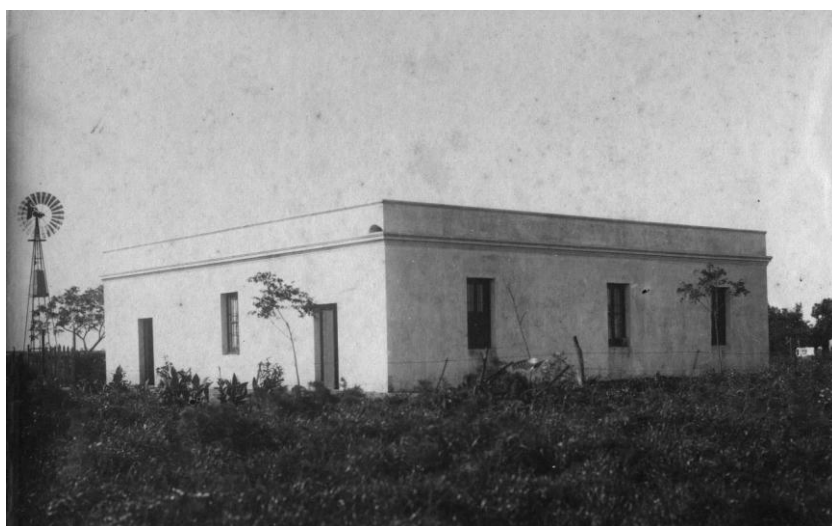
La misma casa del lado opuesto. De izquierda a derecha puerta del comedor, ventana dormitorio de varones, puerta dormitorio grande de mujeres, ventana del dormitorio grande, ventana del dormitorio de Gerardo y Jacoba y ventana del la oficina de administración. A la izquierda, fuera de la casa, el molino y su tanque australiano.
