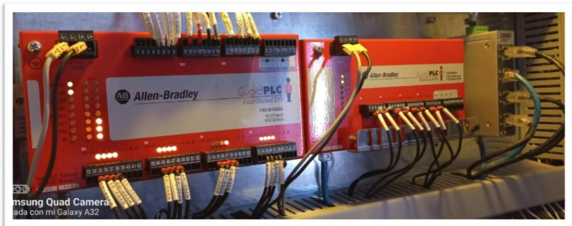
Nota. Izquierda: Modulo IB16XOB8 I/O. Derecha: Modulo OB8 I/O; ambos funcionando en planta.
