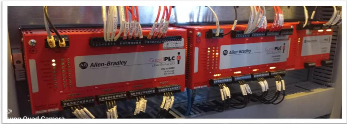
*Nota. Izquierda: Modulo IB16XOB8 I/O, Derecha: Modulo IB16XOB8 I/O; ambos funcionando en planta.*
