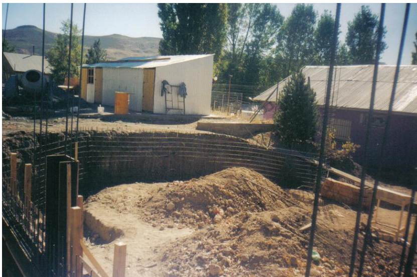
Construcción del SUM de la escuela N° 30.
