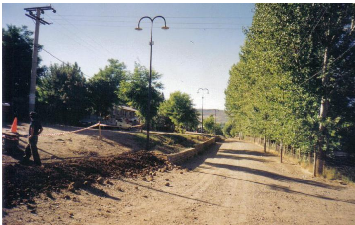
Construcción de canteros en la Avenida Pedernera. 2001.
