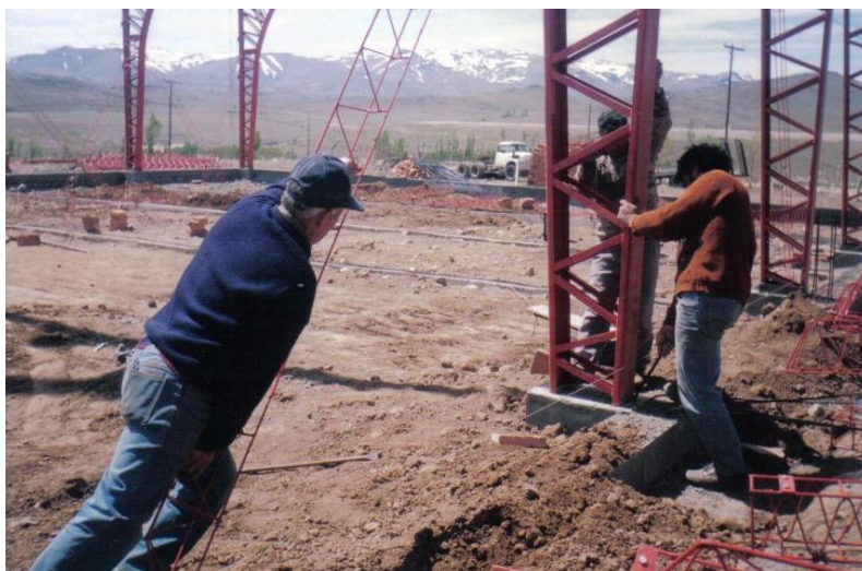
Obreros trabajando en la construcción del gimnasio municipal.
