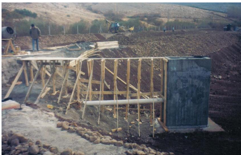
Construcción de las piletas para la obra de cloacas. 1993.
