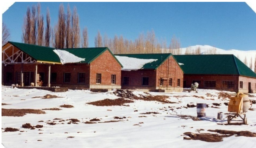
Construcción del edificio de la EPEA.
