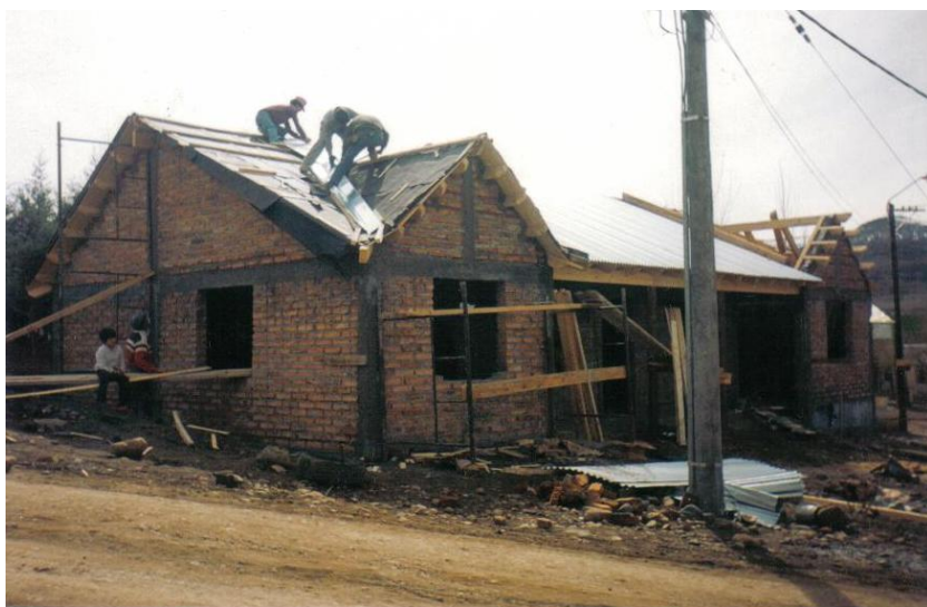
Construcción de la Biblioteca Popular Cerro Los Quiques.
