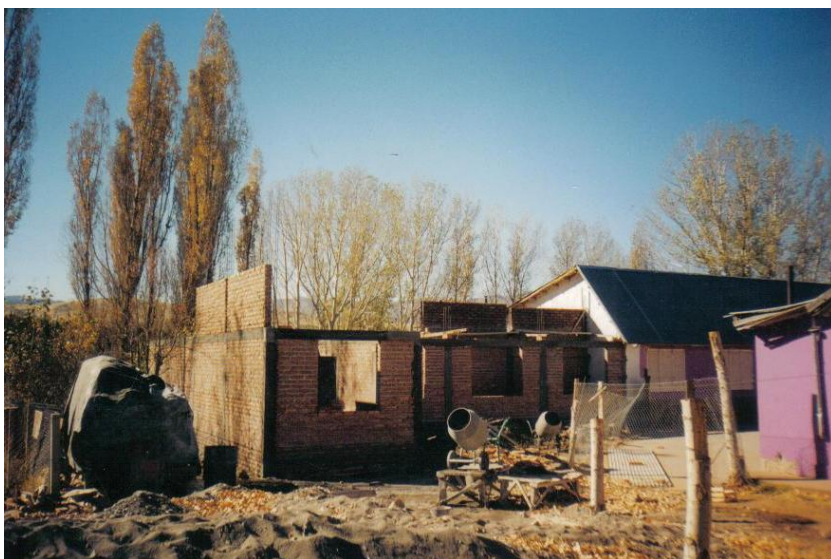
Construcción de aulas en la escuela N° 30.
