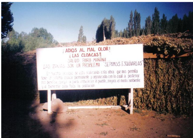
Inicio de la obra de cloacas. 1993.
