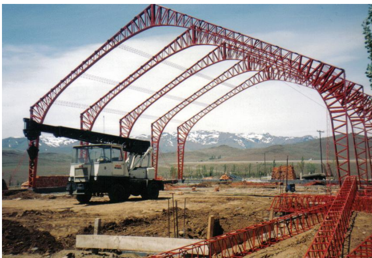
Construcción del gimnasio municipal.
