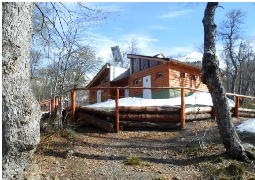
Sanitarios en Las Lagunas de Epulauquen. 2014.
