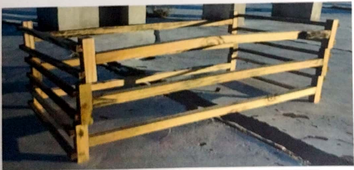
Figura 2- Estructura de madera para soporte de cuerdas de fijación.
