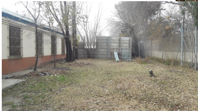
De izquierda a derecha – fila 1 a 4: Fotografías 29, 30 (fila 1), 31 y 32 (fila 2). Patio correspondiente al pabellón general. Fotografías 33 y 34 (fila 3). Cocina y comedor pabellón 6. Fotografías 35 y 36 (fila 3 y 4). Patio correspondiente a pabellón 6.
