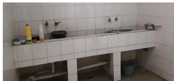
Fotografías 23, 24, 25, 26, 27 y 28 (de fila 1 a 3, de izquierda a derecha). Baños, duchas y sector de lavado pabellón general.
