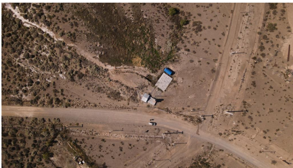
Figura 17. Fotografía desde dron de la zona de rebombeo actual.
