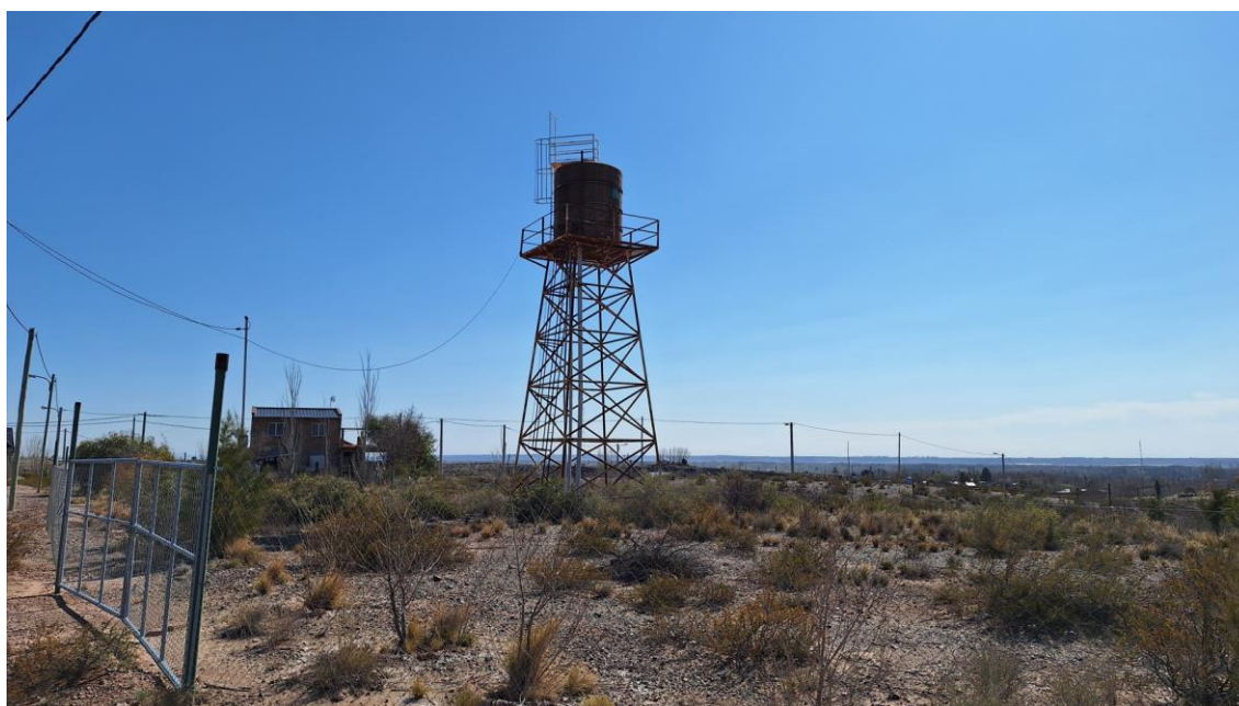
Figura 21. Tanque elevado existente en barrio Muten II.
