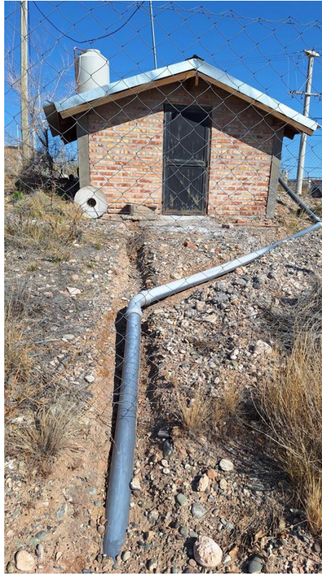
Figura 20. Fotografía de la zona donde comienza la tubería de PVC enterrada actual.
