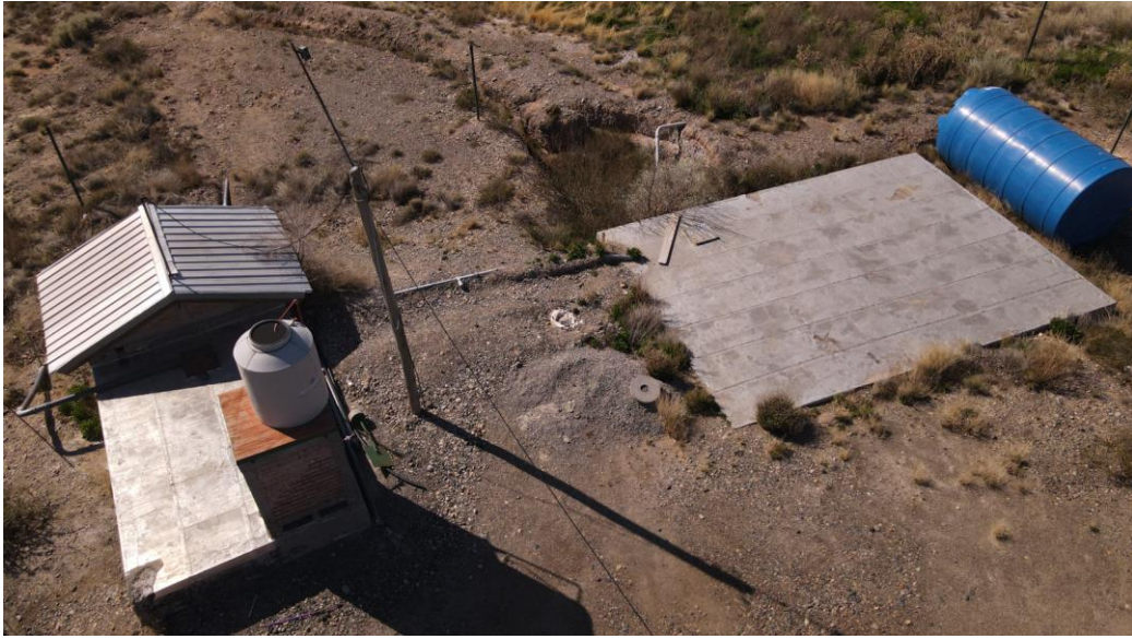
Figura 18. Fotografía en vista superior de zona de bombeo actual.
