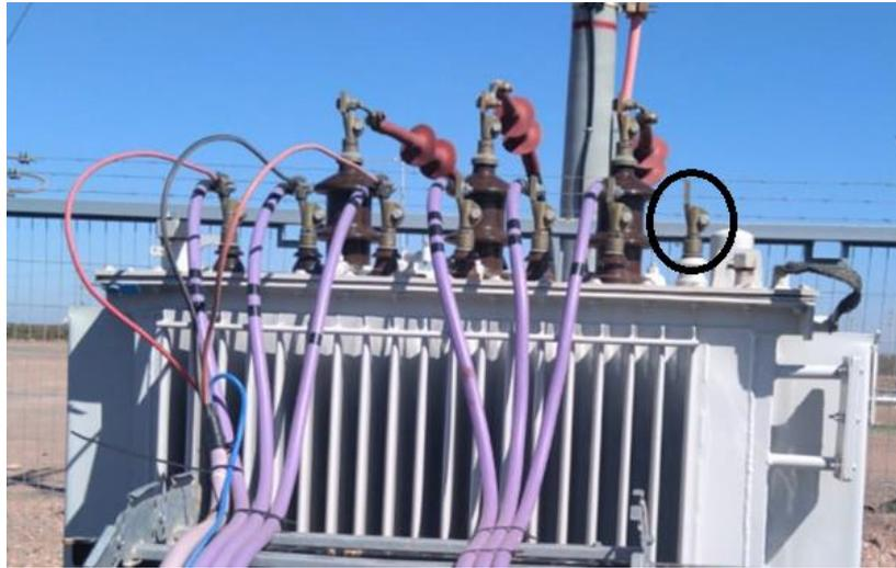
*Ilustración 15-Transformador con Neutro aislado de tierra - ECT IT*
