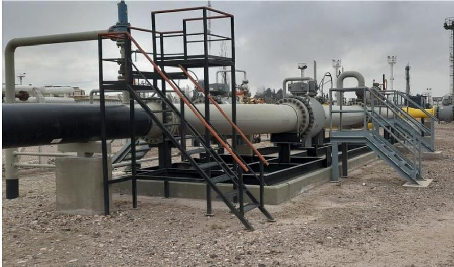
*Ilustración 4-Masa extraña típica: Cañería de hidrocarburos*
