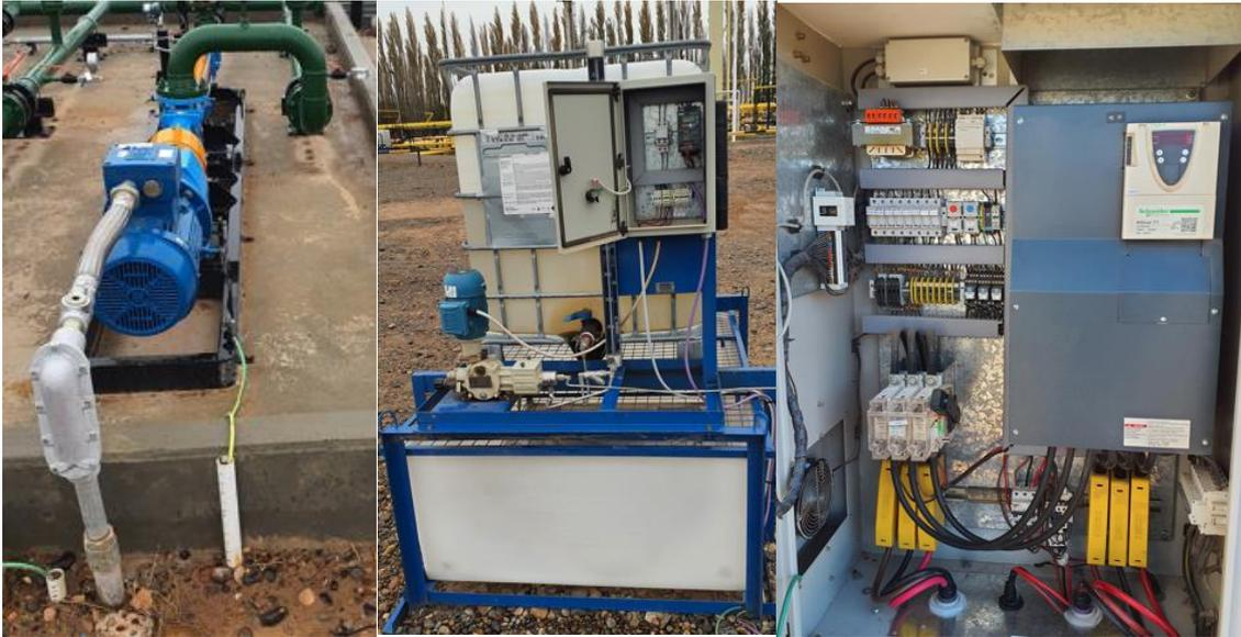
*Ilustración 2-Masas eléctricas típicas: Bomba, dosificador químico y tablero variador de frecuencia.*
