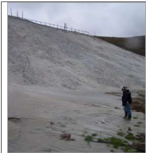
Foto 1: Infiltración de relave (13-10-2006)
