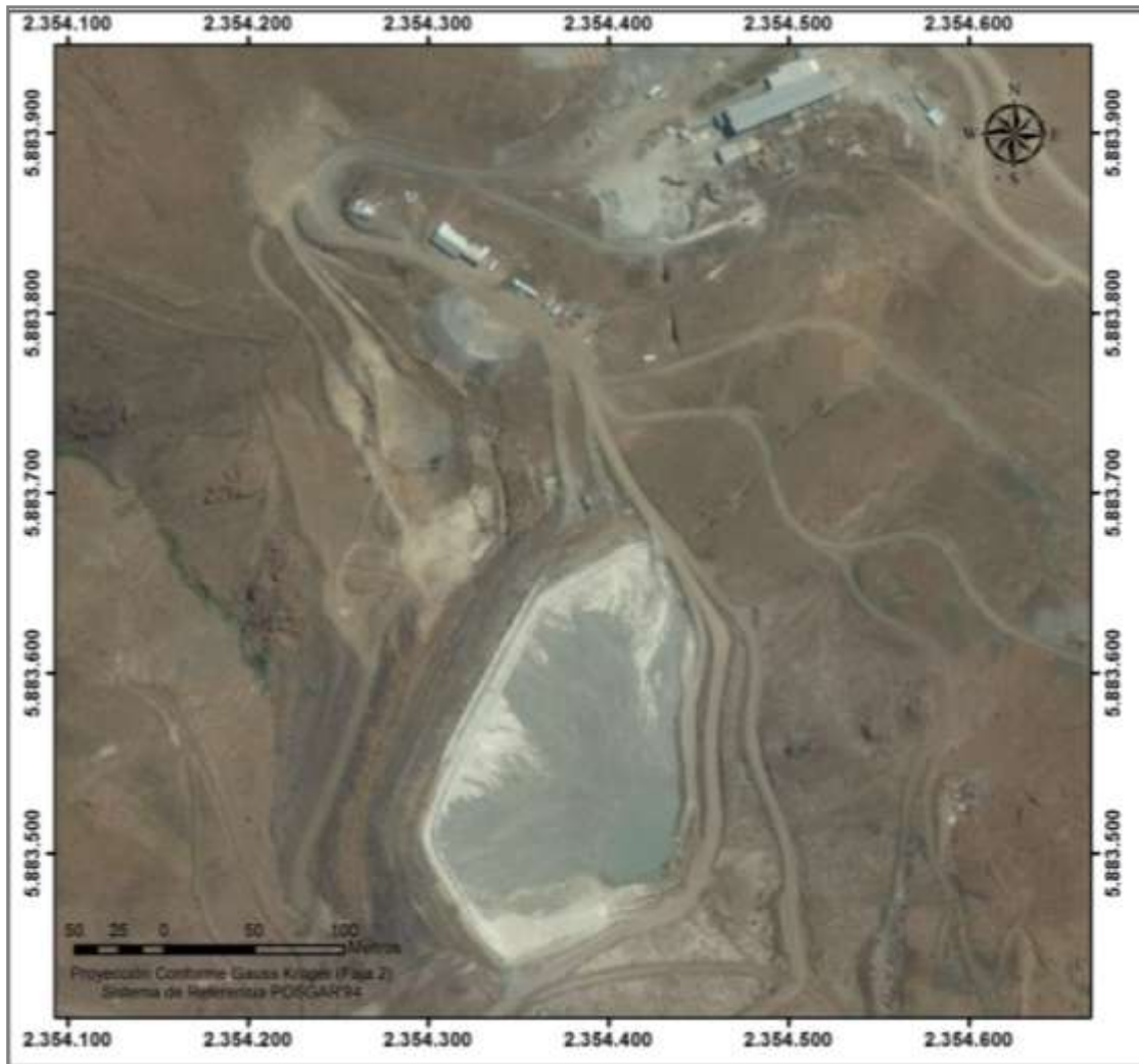
Figura 3: Vista del dique de colas (imagen satelital)
