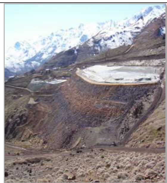
Foto 4: Vista actual del dique (MAGSA)
