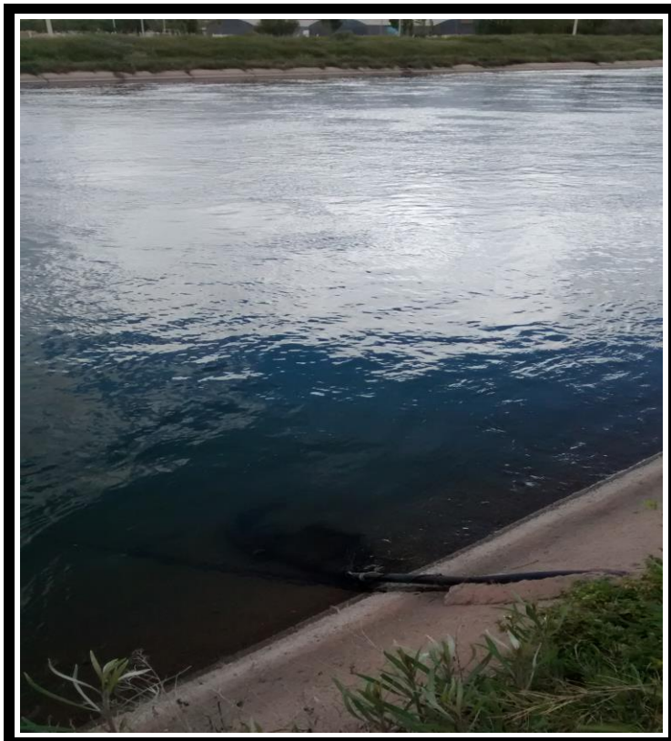
Figura 26: Conexión de cañería para la toma de agua del Canal Principal de Riego.
