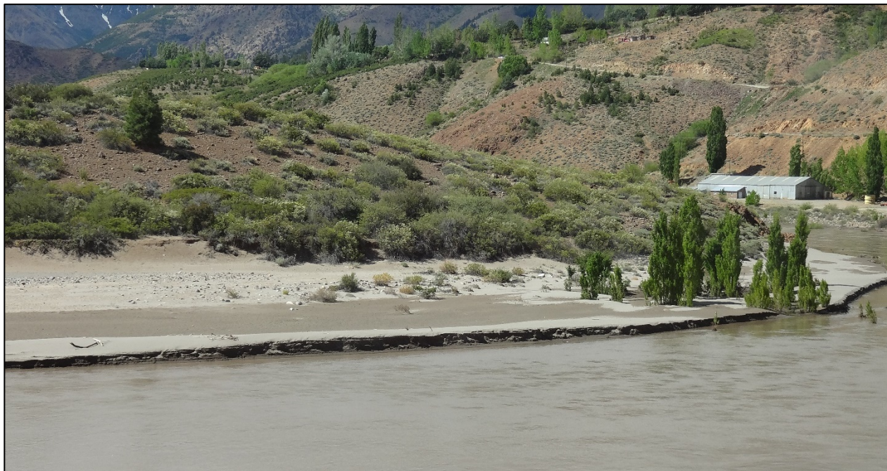
Figura 18: Rasgos de crecida sobre el río Neuquén en cercanías de Huinganco.
