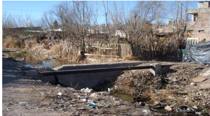
Foto N° 7. Vista Cañadón Cordón Colón. 2007.
